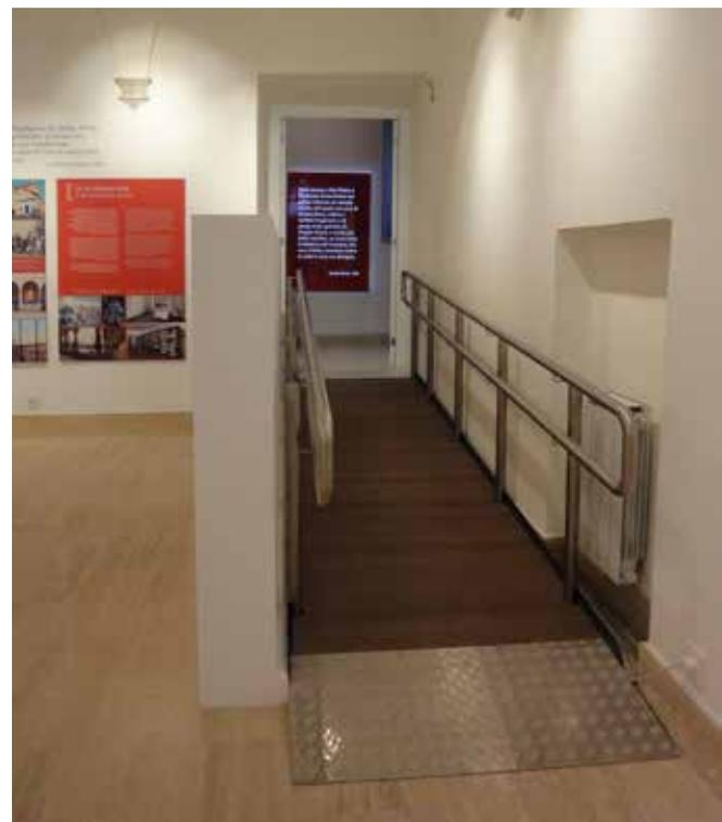
La salida al patio del *Tempietto* se realiza mediante una plataforma de madera que incorpora una rampa para salvar los escalones existentes. Es una pieza de madera maciza y formada por tablero de iroco pasado por autoclave, de espesor 45 mm, con inclusión de resaltes antideslizantes. La rampa dispone de zócalo de protección lateral formado por piezas de madera de 6 x 10 cm.
