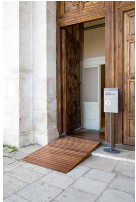
Doble rampa de madera formada por tableros de Iroco tratado en autoclave de 45 mm de espesor, con pendiente del 10% y elementos elásticos de caucho en los apoyos para proteger los pavimentos históricos.
