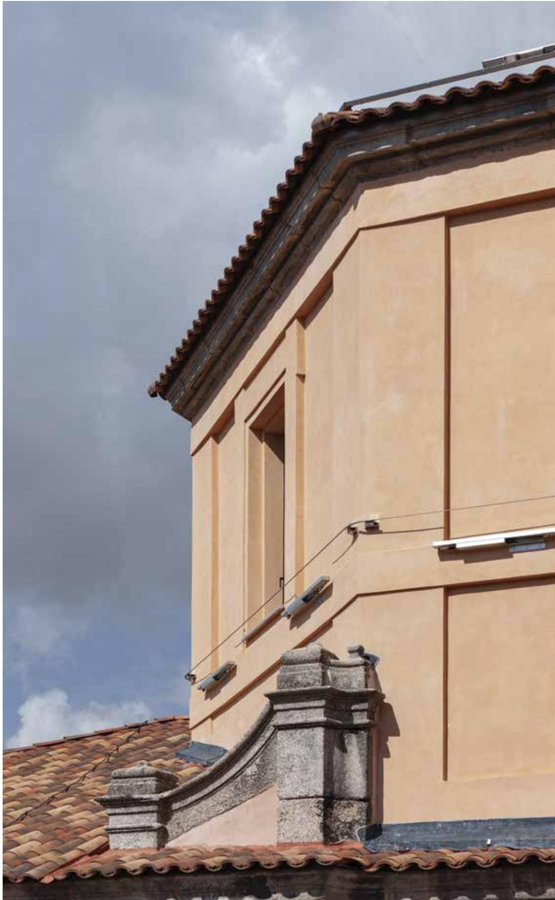
Detalle exterior del ochavo, con nueva iluminación exterior, mortero restaurado, línea de seguridad y encuentros sellados.
