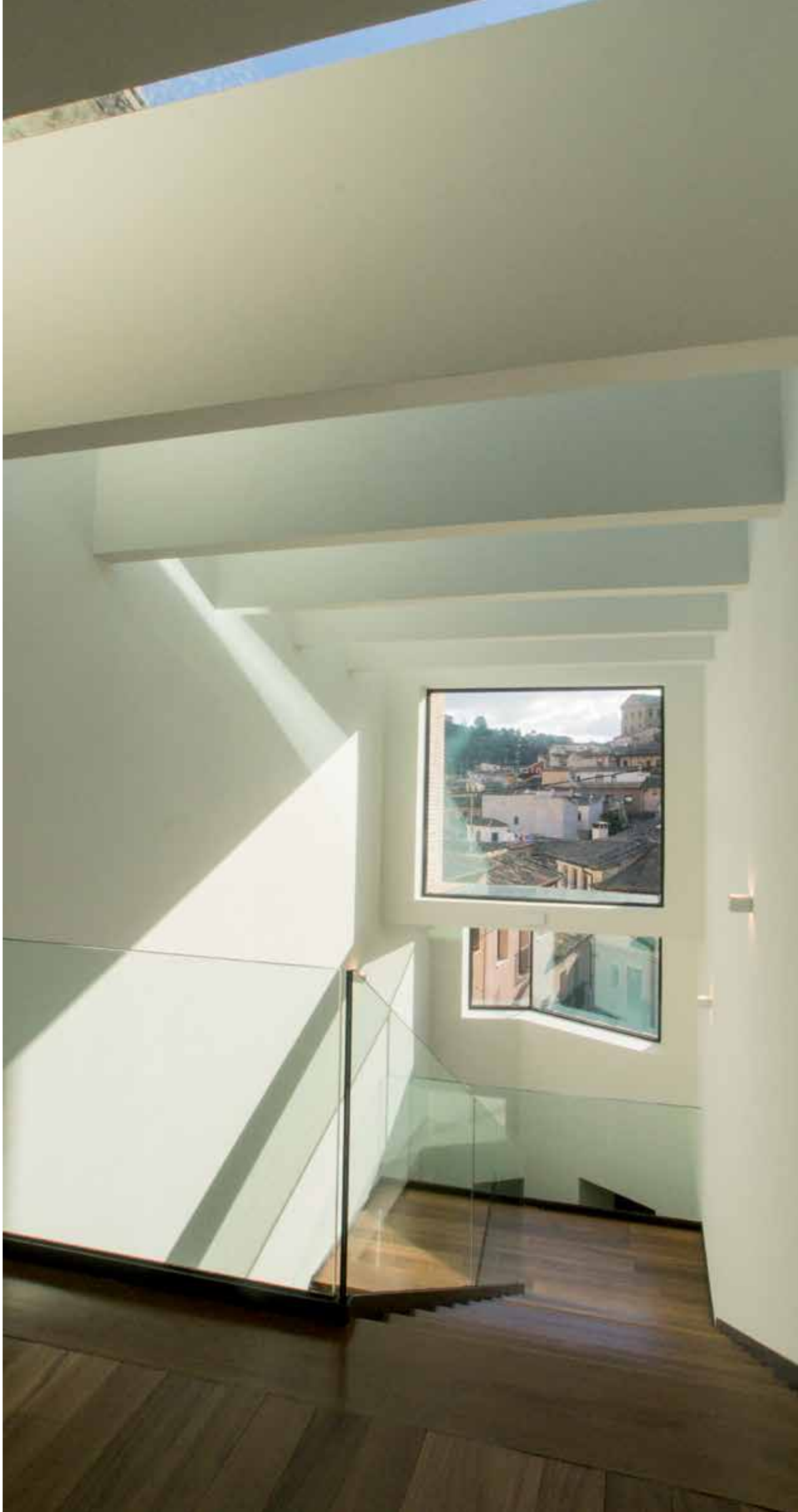
Nuevo núcleo de escaleras en antiguo patio secundario.
