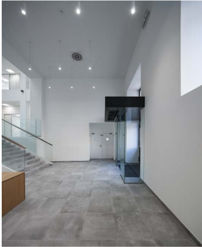
Nuevo cortavientos en vestíbulo de entrada.
