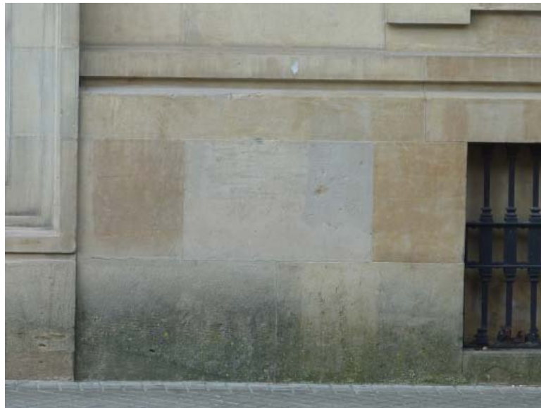
Limpieza de fachadas y proyección de consolidante e hidrofugante.
