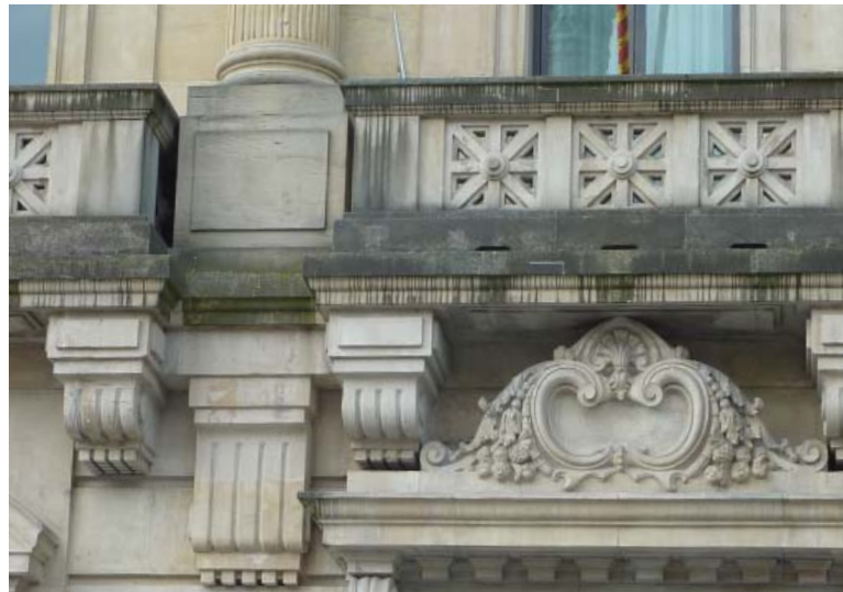
Limpieza de fachadas, sustitución de carpinterías y restauración de cerrajería original.
