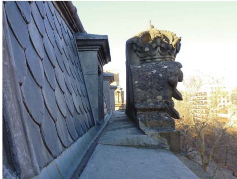
Incorporación de baberos de zinc con formación de goterón.
