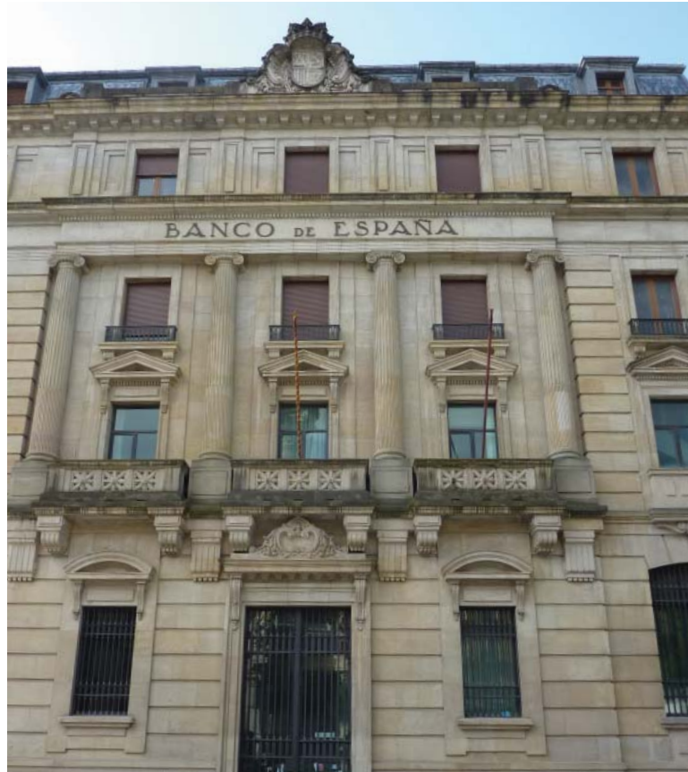
Limpieza de fachadas, cosido y retacado de elementos.
