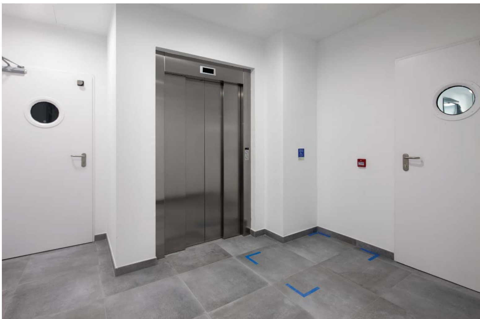
Zonas de refugio para personas con movilidad reducida junto a ascensor accesible para su evacuación segura.
