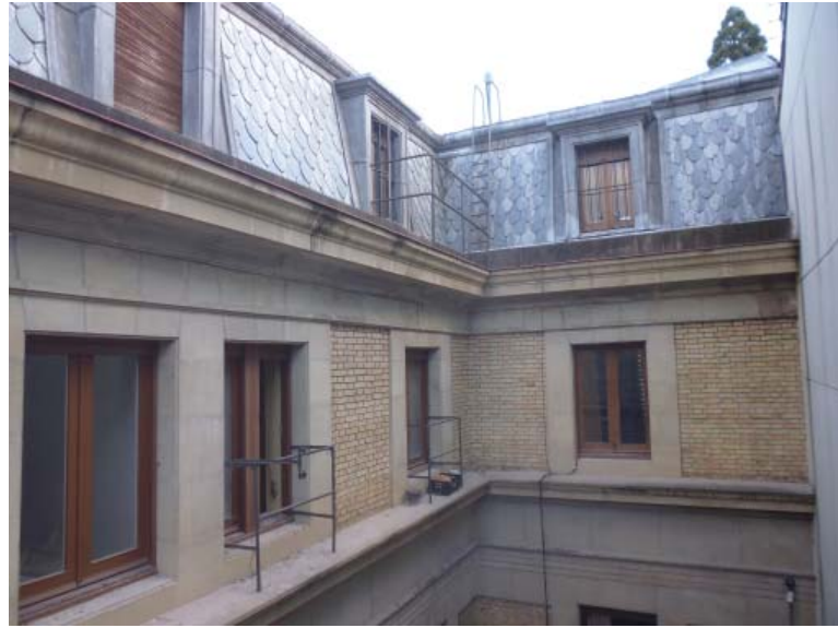
Recuperación de huecos originales en patio de remesas.
