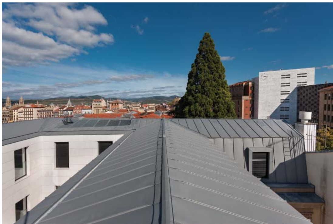
Cubierta rehabilitada de zinc, según volumetría original.
