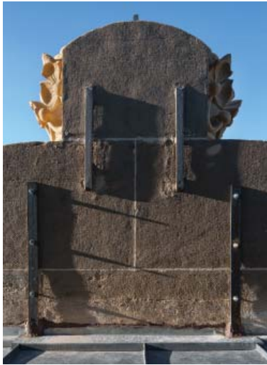
Fijación del escudo en la fachada principal.
