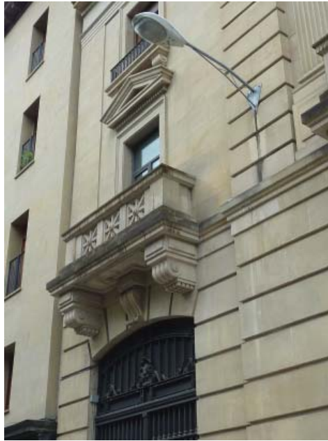
Limpieza de fachadas y consolidación de elementos ornamentales.
