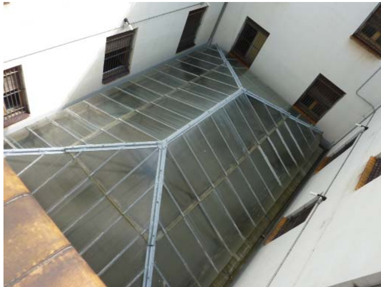
Sustitución del lucernario del patio interior.
