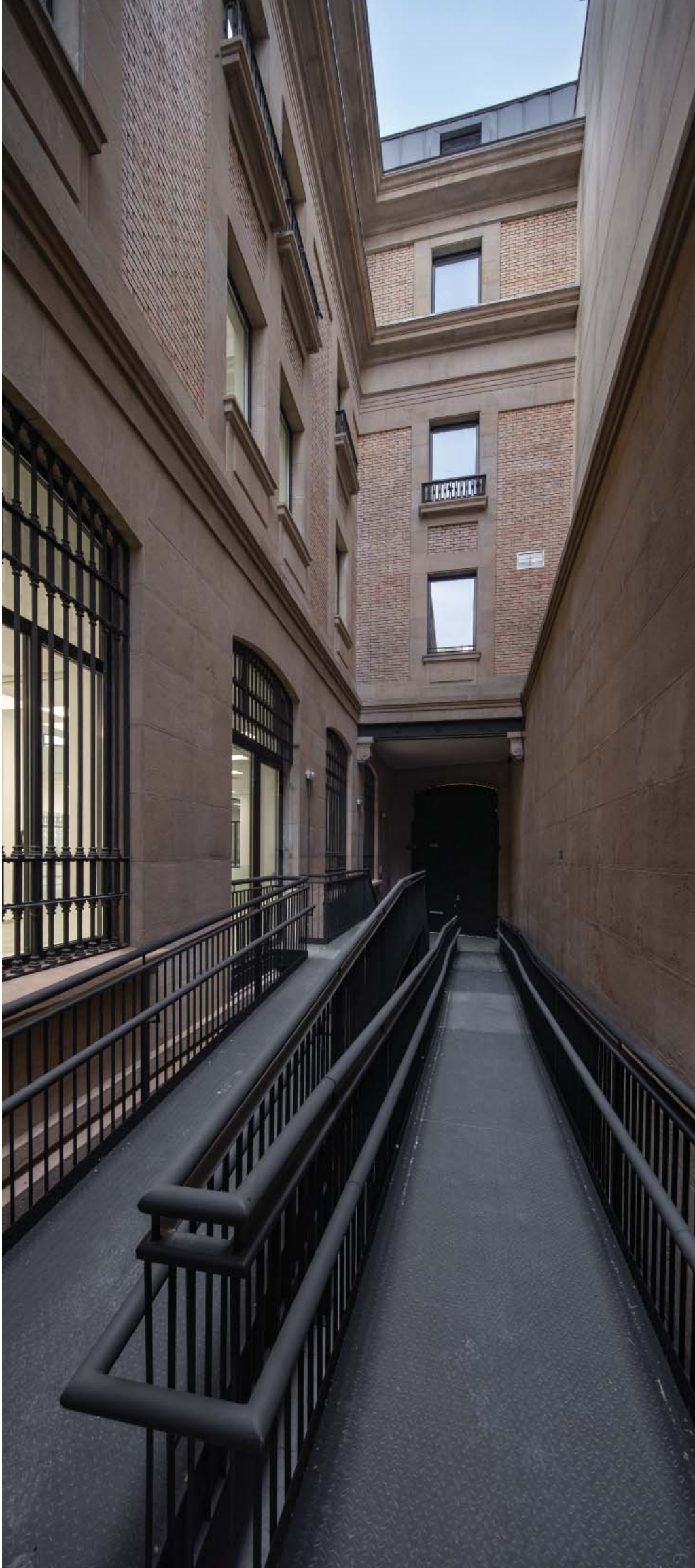
Patio de remesas rehabilitado como salida de emergencia accesible y apertura de huecos originales.
