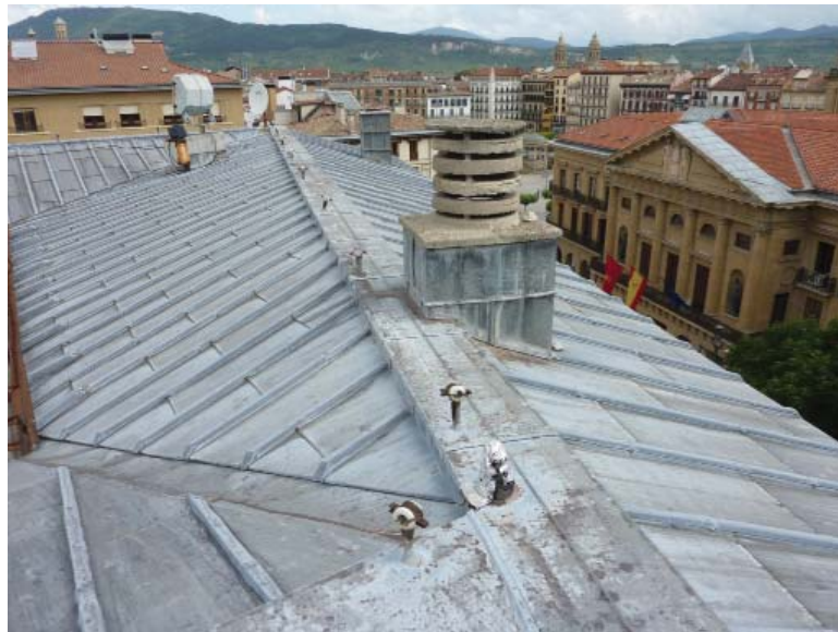
Sustitución de cubierta original de zinc y pizarra por una de zinc, conservando la volumetría original.
