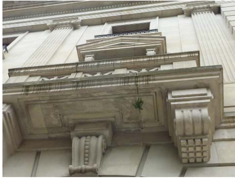
Limpieza de fachadas y ornamentación.
