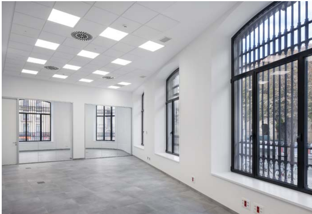
Trasdosado de fachadas originales con aislamiento y pladur. Renovación de carpinterías.
