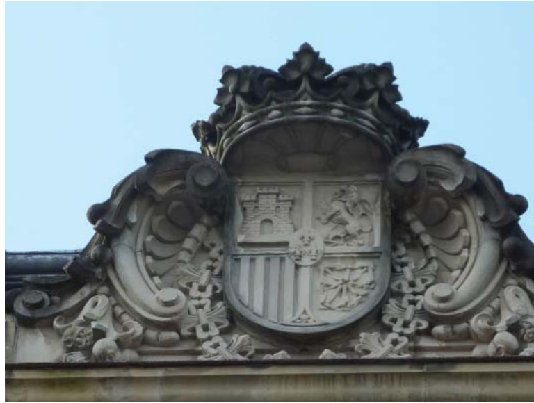
Limpieza y fijación de elementos ornamentales.
