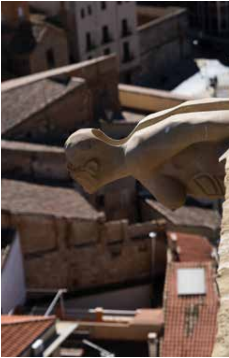
Gárgola repuesta en la reciente restauración.
