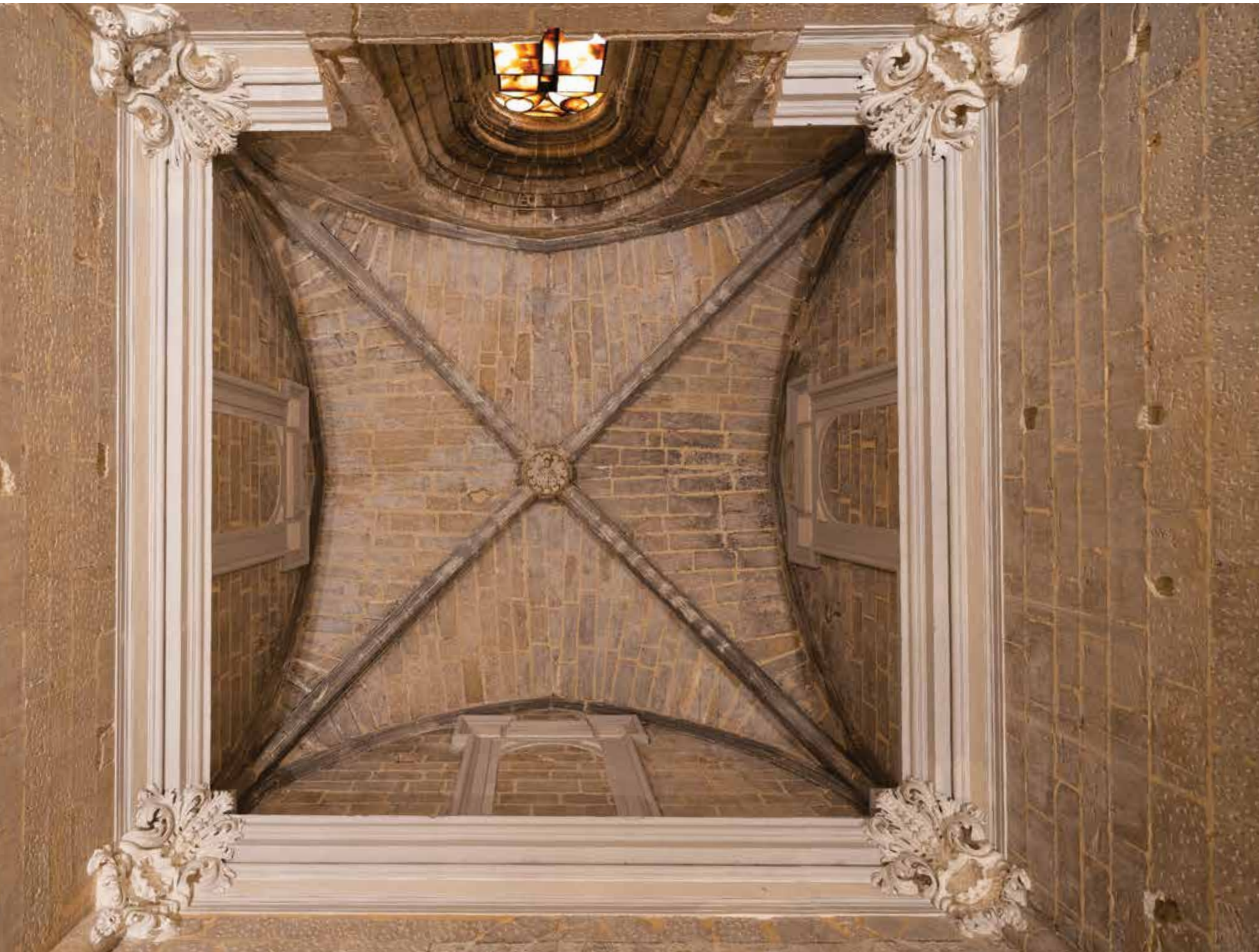
Bóveda de la planta baja.
