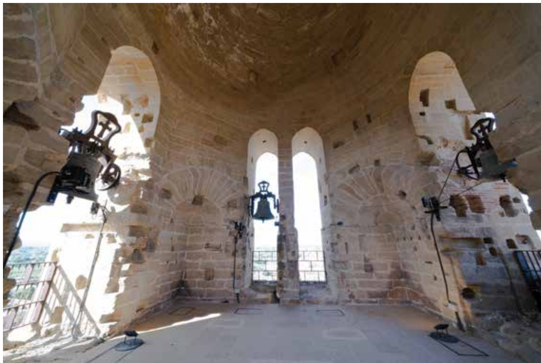
Planta tercera, campanario.
