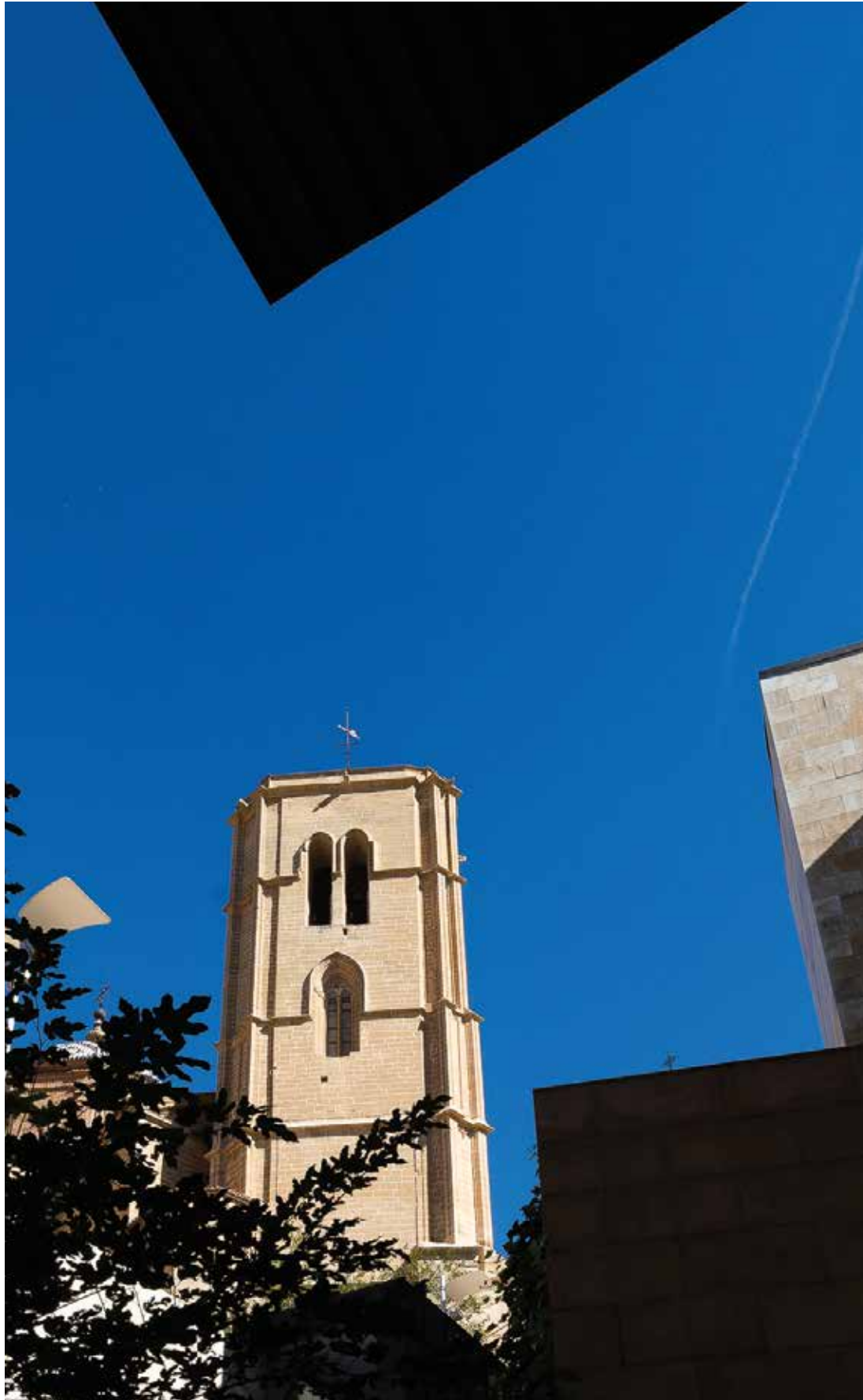
Vista de la torre, plantas superiores del lateral occidental.
