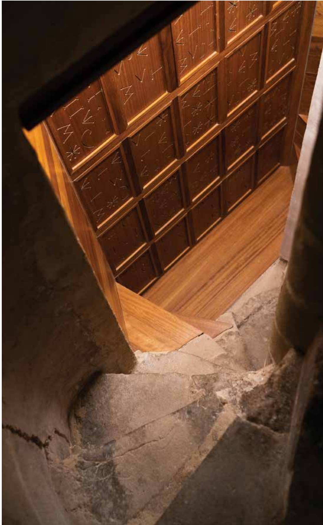
Ampliación de la escalera helicoidal.
