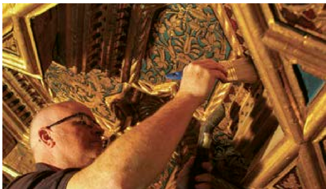
Trabajos de aspirado y limpieza con brocha.
